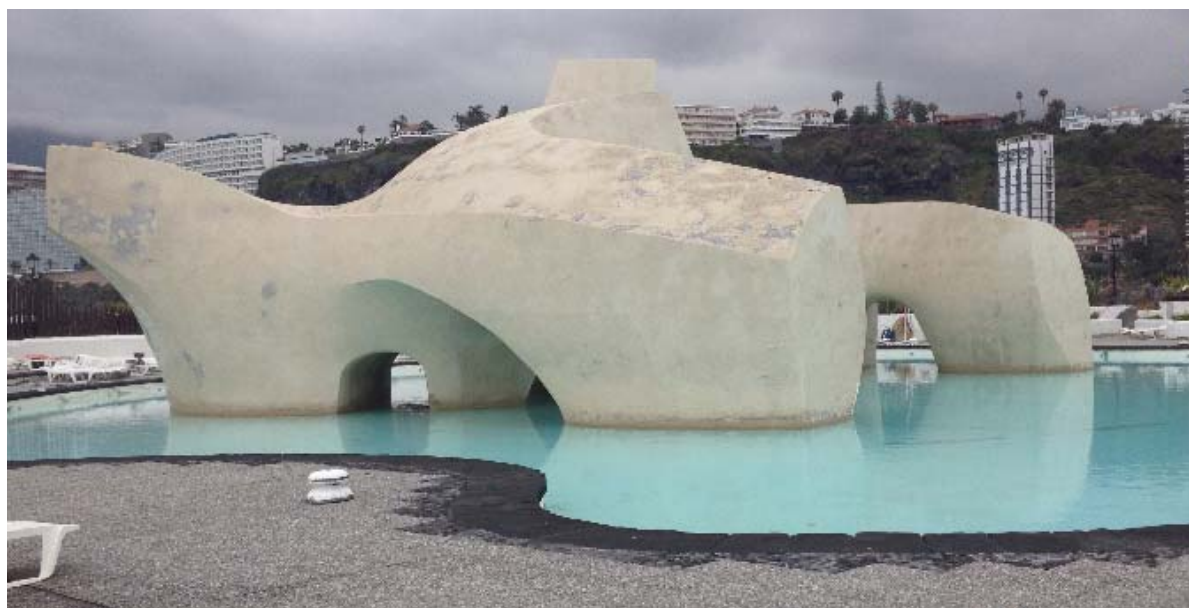
Vista general antes de la actuación
